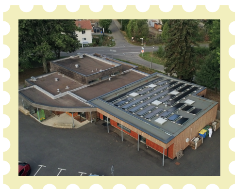
Installation des panneaux solaires en 2020
