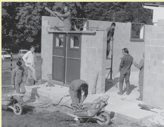
Construction des douches adossées à la salle de sports par les jeunes - 1980
